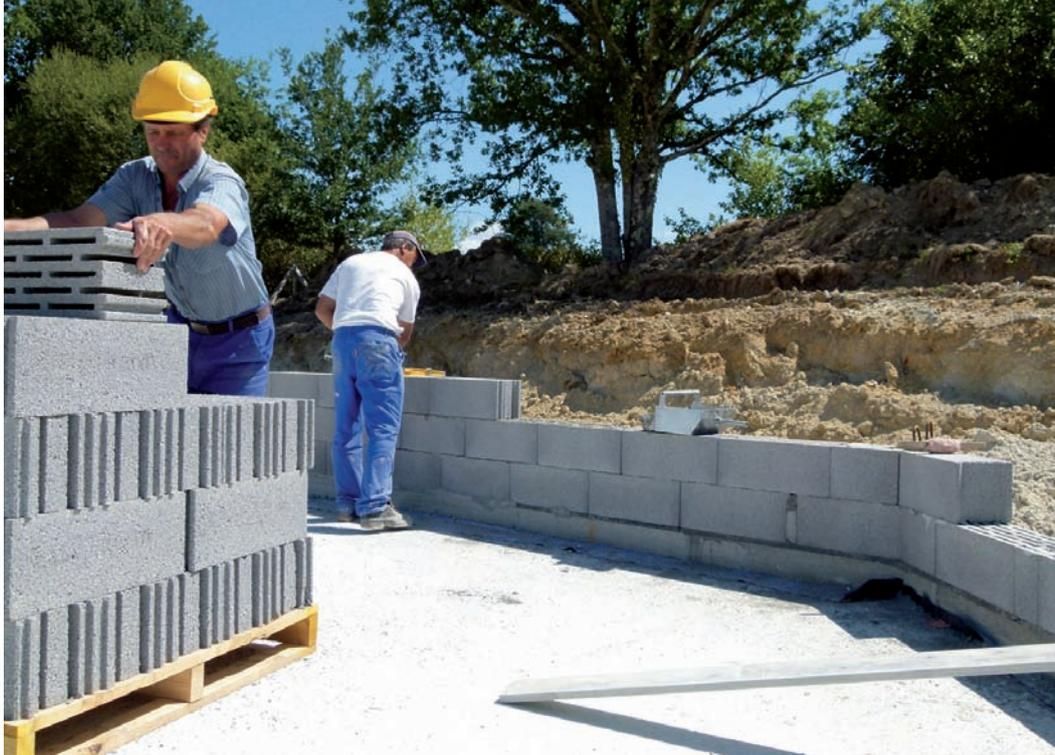
◀ Easytherm® conçu par BIP Bétons, à partir d'un CEM I 52.5 N de Ciments Calcia, facilite le travail des maçons et l'organisation des chantiers grâce à sa légèreté (12,5 kg pour un bloc standard de 20 cm) et sa facilité de mise en œuvre (pose collée).
